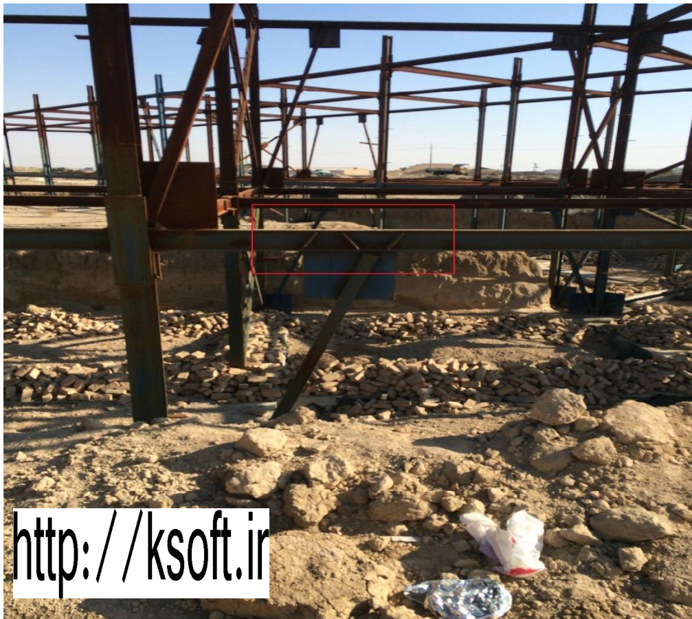
شکل شماره 26: اجرا ی نادرست سخت کننده‌ها در مهاربند واگرا
