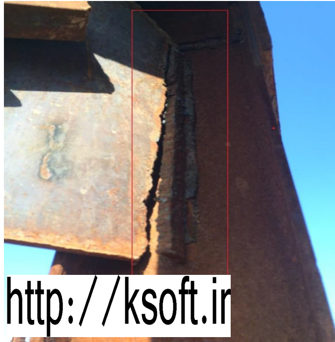
شکل شماره 25: پارگی و جدانشدگی ورق اتصال از ستون
