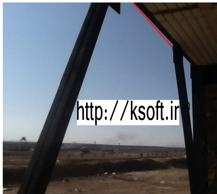
شکل شماره 11: طول زیاد تیر پیوند و تغییر رفتار تیر پیوند از حالت برشی به خمشی
