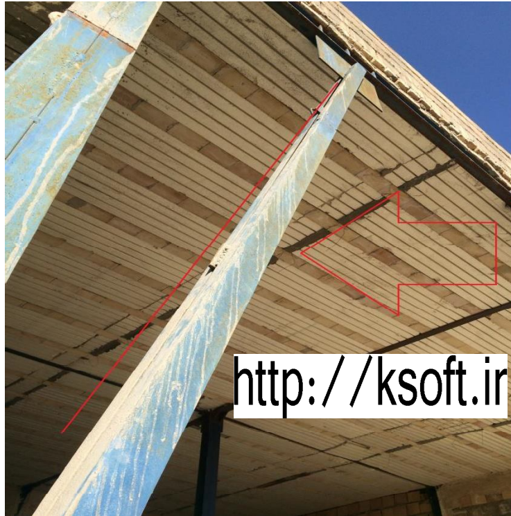
شکل شماره 10: نداشتن بست کافی مابین دو ناودانی 80
