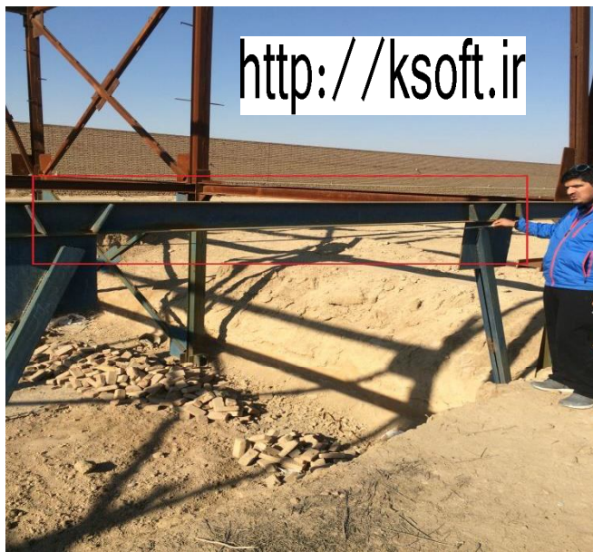
شکل شماره 22: طول بیش از اندازه تیر پیوند در مهاربند های و اگر و تغییر رفتار تیر پیوند از رفتار برشی به خمشی
