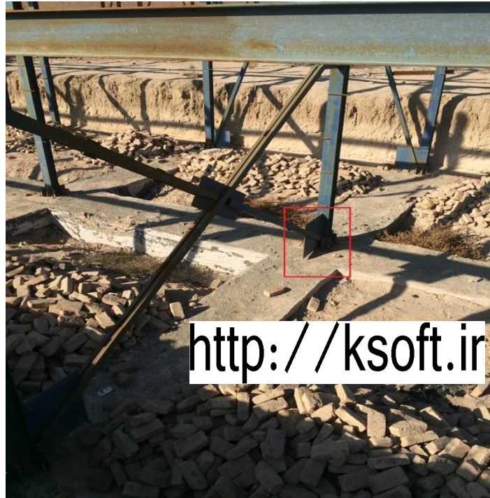
شکل شماره 18: عدم اتصال ورق باد بند به فونداسیون و صفحه ستون
