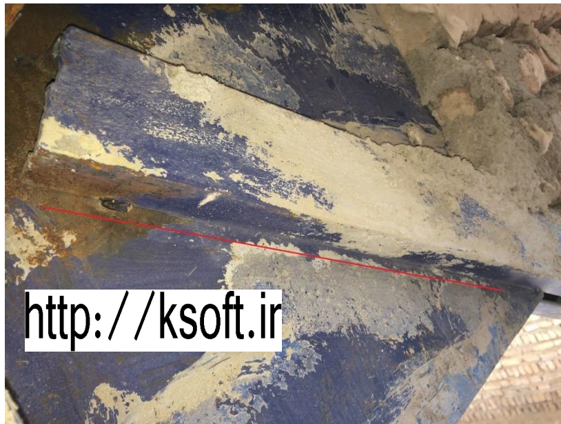
شکل شماره 9: نداشتن جوش اتصال بادبند به ورق اتصال
