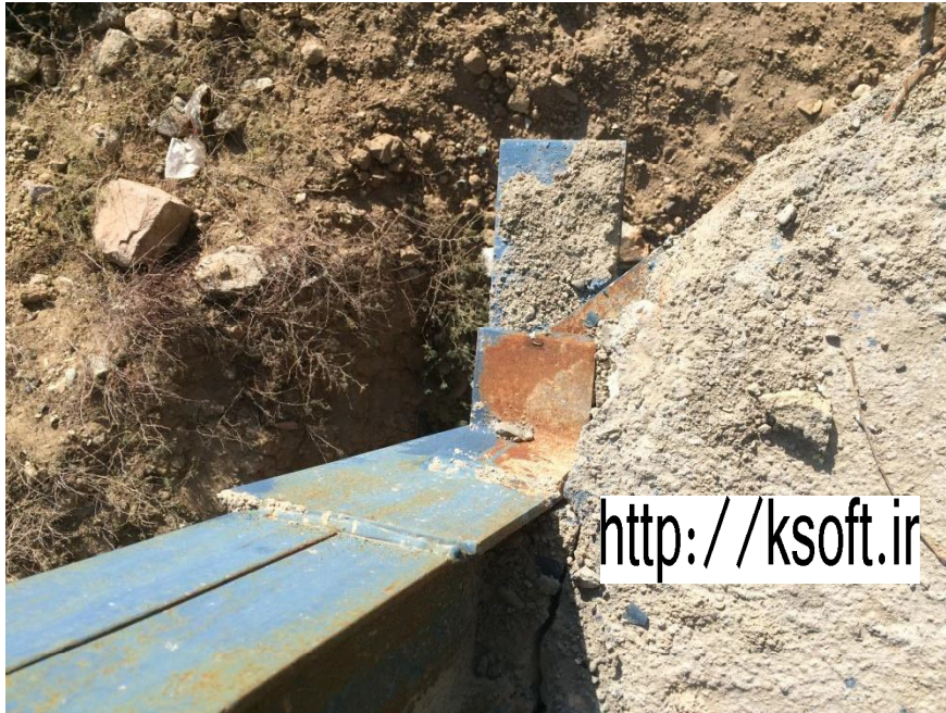
شکل شماره 7: خرد شدن قسمتی از سقف بر اثر تغییر شکل تیر و دوران اتصال
