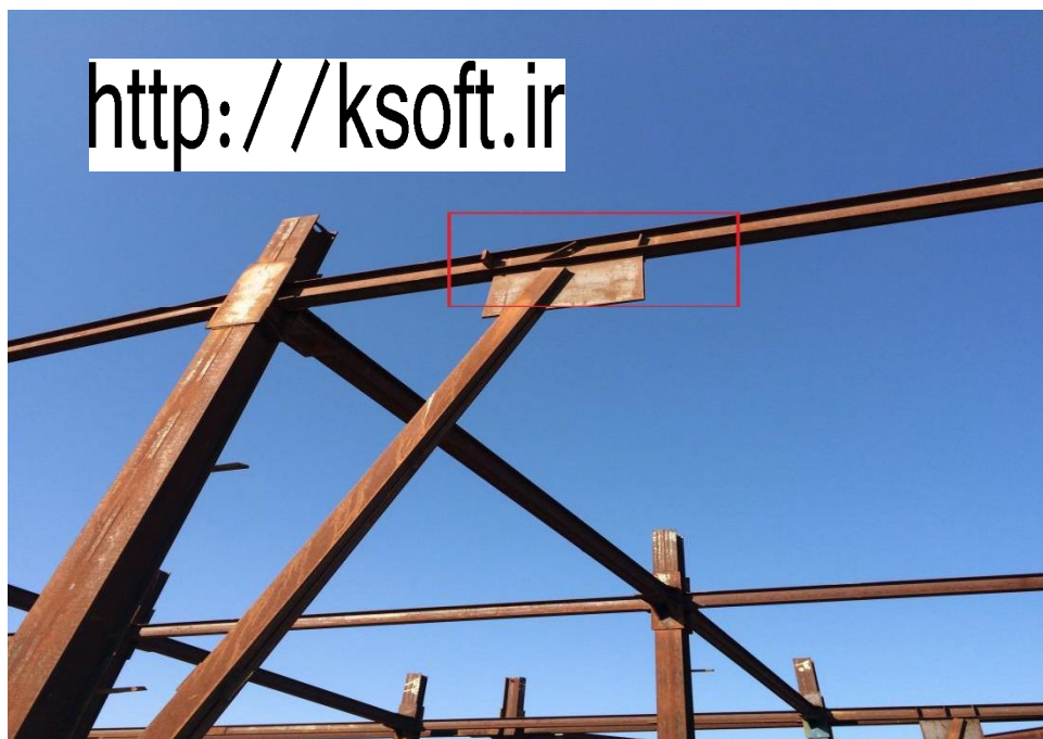
شکل شماره 20: اجرای نادرست سخت کننده‌ها در مهاربند و آگرا
