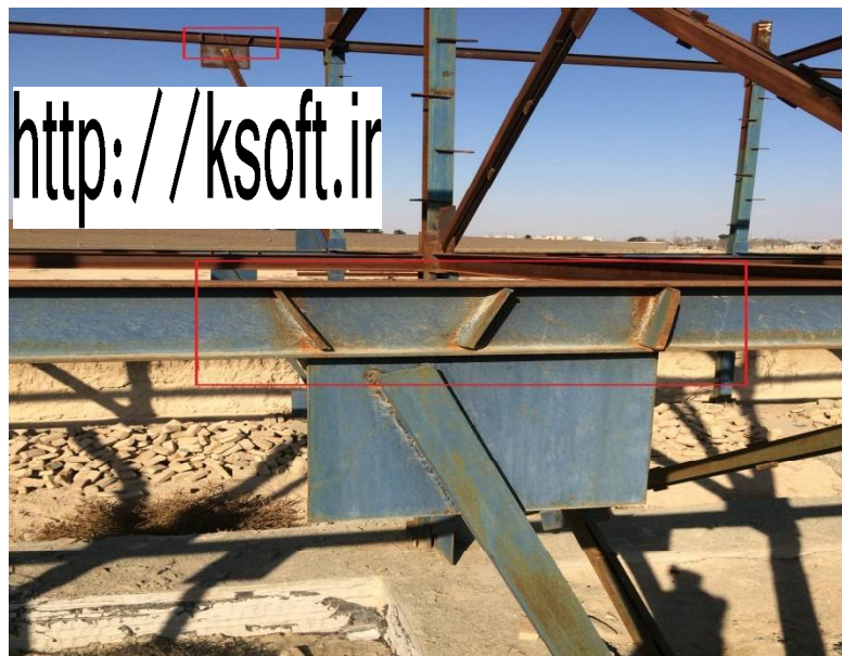
شکل شماره 19: اجرای نادرست سخت کننده‌ها در مهار بند و اگر
